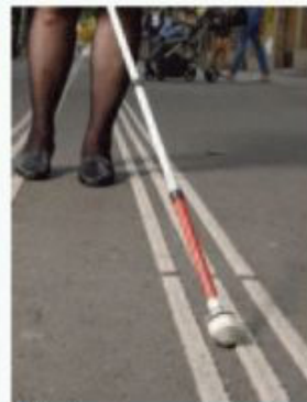
A Sion, la canne court le long de la ligne de guidage pour aider les aveugles à se déplacer sur les trottoirs.
