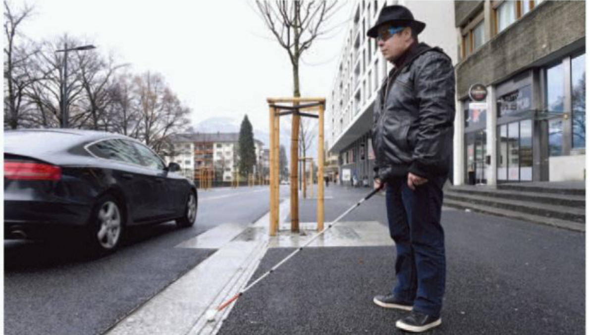
Les bandes de séparation remplacent les points de repère constitués par les trottoirs dans cette zone de rencontre limitée à 20 km/h.
